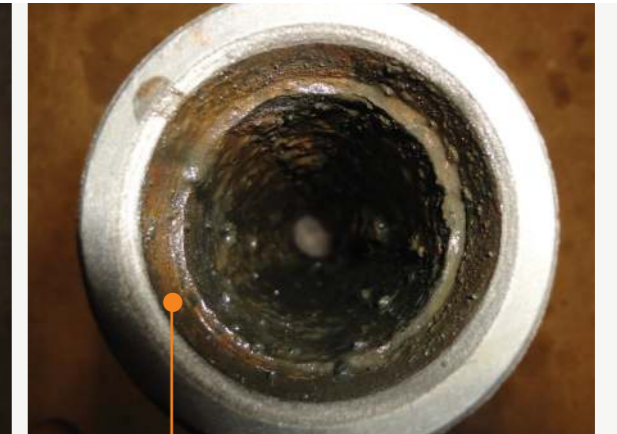
24 Monate nach der Installation von Aqua4D®
