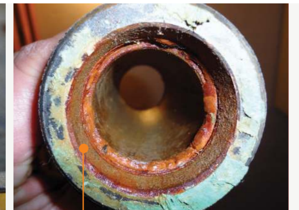
36 Monate nach der Installation von Aqua4D®
