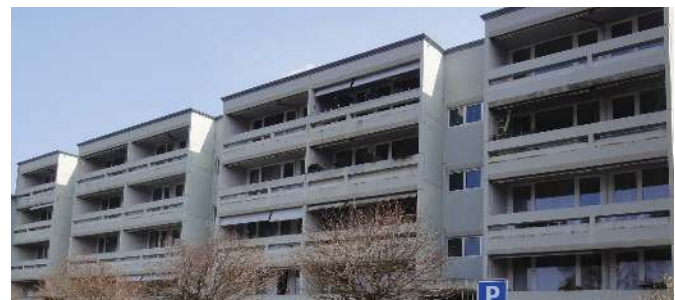
Installation in einem Gebäude im Kanton Bern
