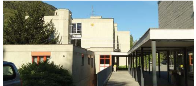
Installation in einem öffentlichen Gebäude der Berufsschule in Visp im Wallis
