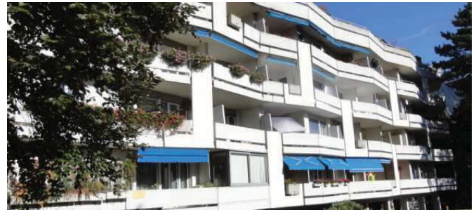
Installation in einem Mietgebäude in Sierre
