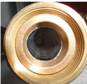
Das Kontrollrohr wurde in der Warmwasserleitung installiert
