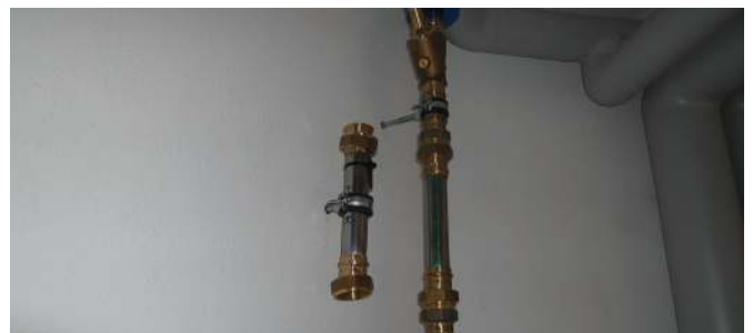
Installation eines Kontrollrohres im Warmwasser
